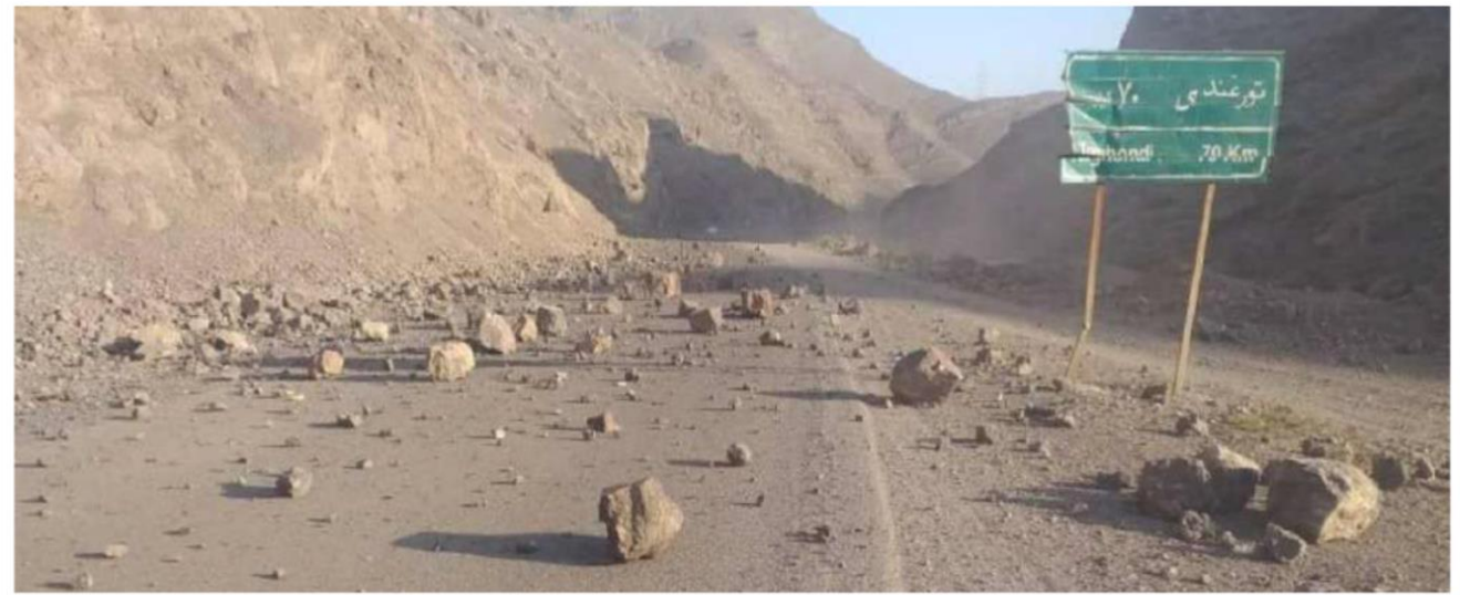
شکل ۲۱: ریزشهای سنگی در جاده ارتباطی به تورغندی در اثر زلزله بامداد یازدهم اکتبر ۲۰۲۳ هرات، برگرفته از سایت چند ثانیه
