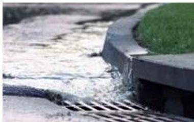
**سیستم زهکشی زیر آبزنشی:** این سیستم بشكل طبیعی و ساخت بشر وجود دارد که باعث می‌شود در زمان بارندگی‌ها آب را از سطح زمین به زیر زمین انتقال دهد، در نوع مصنوعی آن آب باران به سیستم کانال‌سیون منتقل می‌شود و سبب کاهش خطر سیلاب می‌شود در سیستم زهکشی طبیعی آب به شکاف‌ها و مجرای آب‌های زیر زمینی و کانال‌های طبیعی منتقل می‌شود. امروزه بمنظور مدیریت سیلاب‌های شهری از سیستم‌های زهکشی توسعه کم اثر استفاده صورت می‌گیرد.
